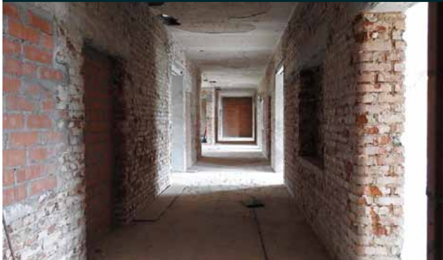
Entkernung Haus C- 2019 KW 06 - Die Handwerker sind nachdem Haus A und Haus B entkernt sind nun bei Haus C angelangt. Das Gebäude wird bis aufs Mauerwerk entkernt. Der Verbindungstrakt zwischen Haus B und Haus C beginnt zu entstehen.
