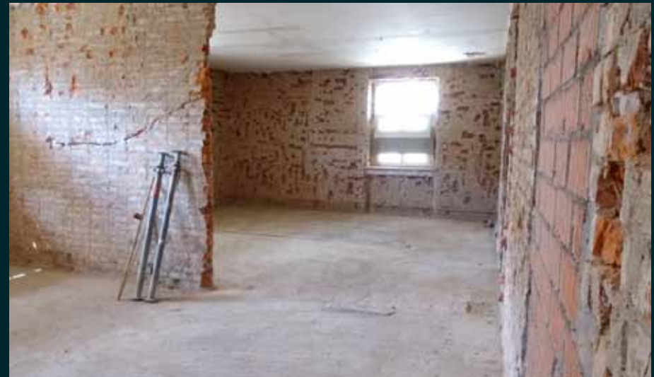
Entkernung Haus C- 2019 KW 06 - Die Handwerker sind nachdem Haus A und Haus B entkernt sind nun bei Haus C angelangt. Das Gebäude wird bis aufs Mauerwerk entkernt. Der Verbindungstrakt zwischen Haus B und Haus C beginnt zu entstehen.
