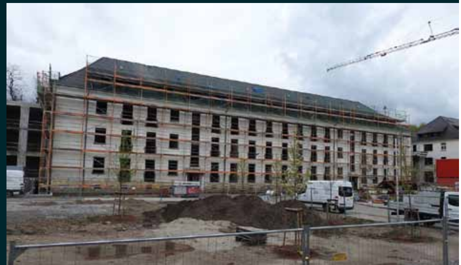
Entkernung abgeschlossen- 2019 KW 14- Die Handwerker arbeiten sich langsam zu Haus C durch. Das Verbindungsgebäude zwischen Haus A und Haus B steht im Rohbau. Beide Häuser sind eingerüstet. Die Verbindung von Haus B zu Haus C ist ebenfalls im Rohbau befindlich. Haus C ist komplett entkernt.
