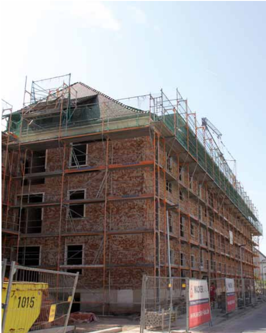
Fassadenarbeiten- 2019 KW 26- In Haus B sind die Fenster gesetzt und die Installateure Sanitär sind fleißig am Werk. Die einzelnen Gewerke arbeiten sich so Haus für Haus weiter. Haus C ist vollständig eingerüstet und der alte Putz an der Fassade ist bereits komplett entfernt.
