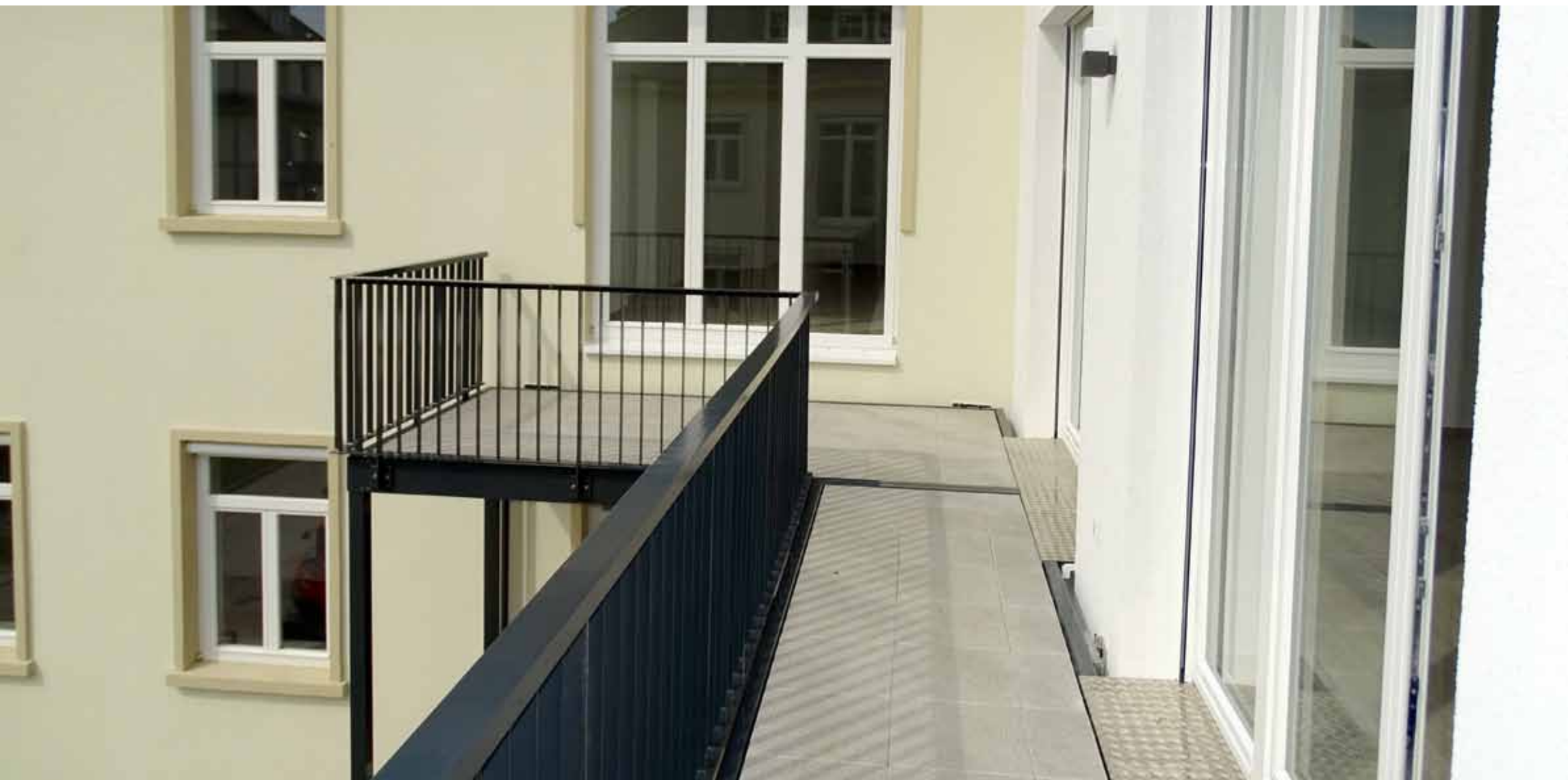
Haus C – 2019 KW 42- In Haus C sind die Trockenbauer fleißig am Werk. Die Fester sind gesetzt und jetzt können alle Gewerke im Innern fleißig Hand in Hand arbeiten.
