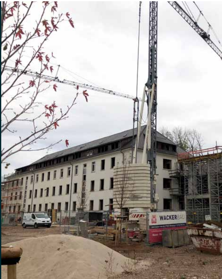
Entkernung abgeschlossen- 2019 KW 14- Die Handwerker arbeiten sich langsam zu Haus C durch. Das Verbindungsgebäude zwischen Haus A und Haus B steht im Rohbau. Beide Häuser sind eingerüstet. Die Verbindung von Haus B zu Haus C ist ebenfalls im Rohbau befindlich. Haus C ist komplett entkernt.
